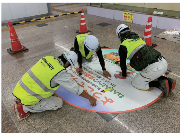
施工状況：告知広告 φ2000mm
