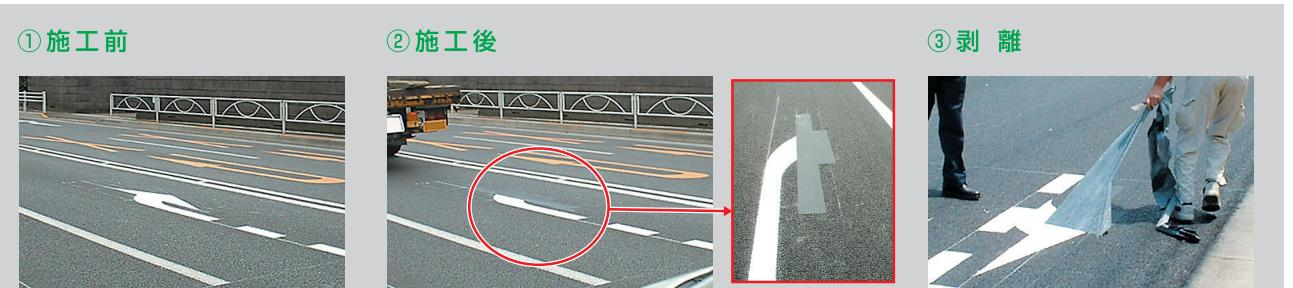
サポートライン黒を使えば、中央線・側線・矢印全部引き終わっても、矢印の先を隠すことが可能で、そのため供用区間開通時に、矢印だけを引きにいく手間が省けます。また少ない人員で設置と撤去が可能なため、コスト面にもメリットがあります。
