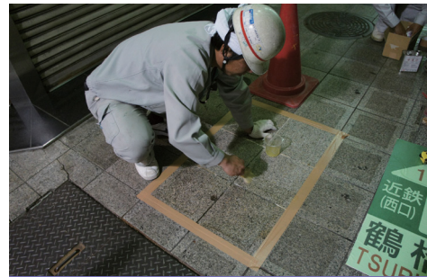
① プライマーを塗布
