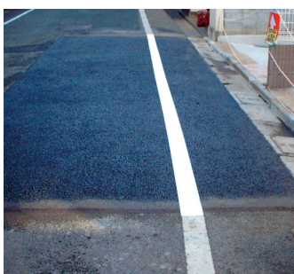
舗装直後の仮ライン標示
