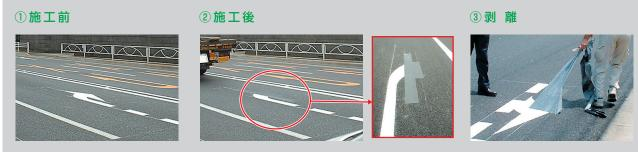
サポートライン黒を使えば、中央線・側線・矢印全部引き終わっても、矢印の先を隠すことが可能です。そのため供 用区間 開通時に、矢印だけを引きにいく手間が省けます。また少ない人員で設置と撤去が可能なため、コスト面に もメリットがあります。
