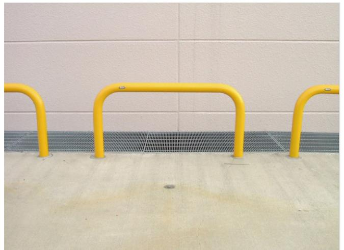
固定式【 $\phi 60.5 \times H800\text{mm}$  スチール製】
