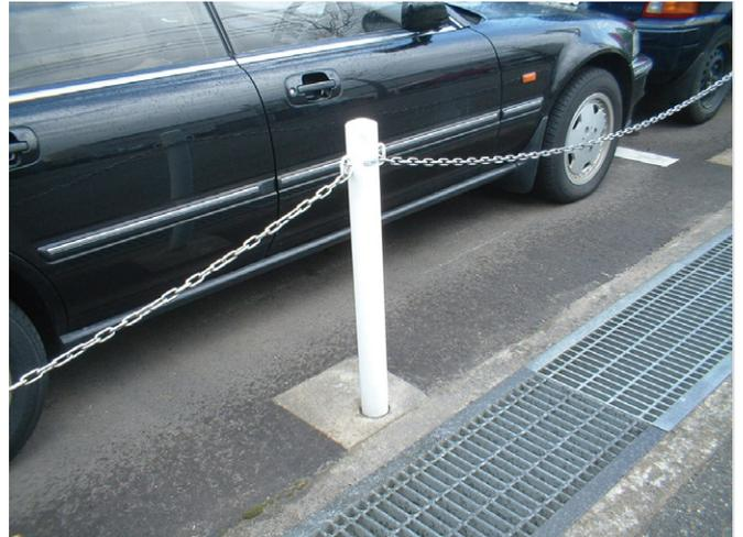
固定式【 $\phi 76.3 \times H850\text{mm}$  スチール製】
