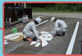
レイアウトを見ながらシートを設置。
