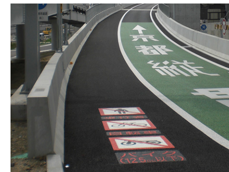
立入禁止 / 京都府 長岡京市
