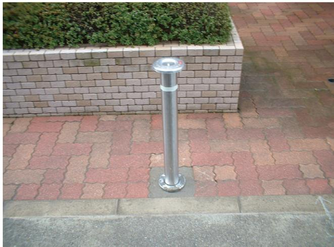
上下式【 $\phi 76.3 \times H850\text{mm}$  スチール製】
