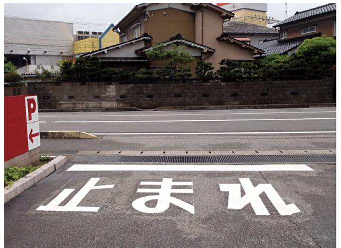
停止線【 W5000×H450mm 溶着式トラフィックペイント 】
