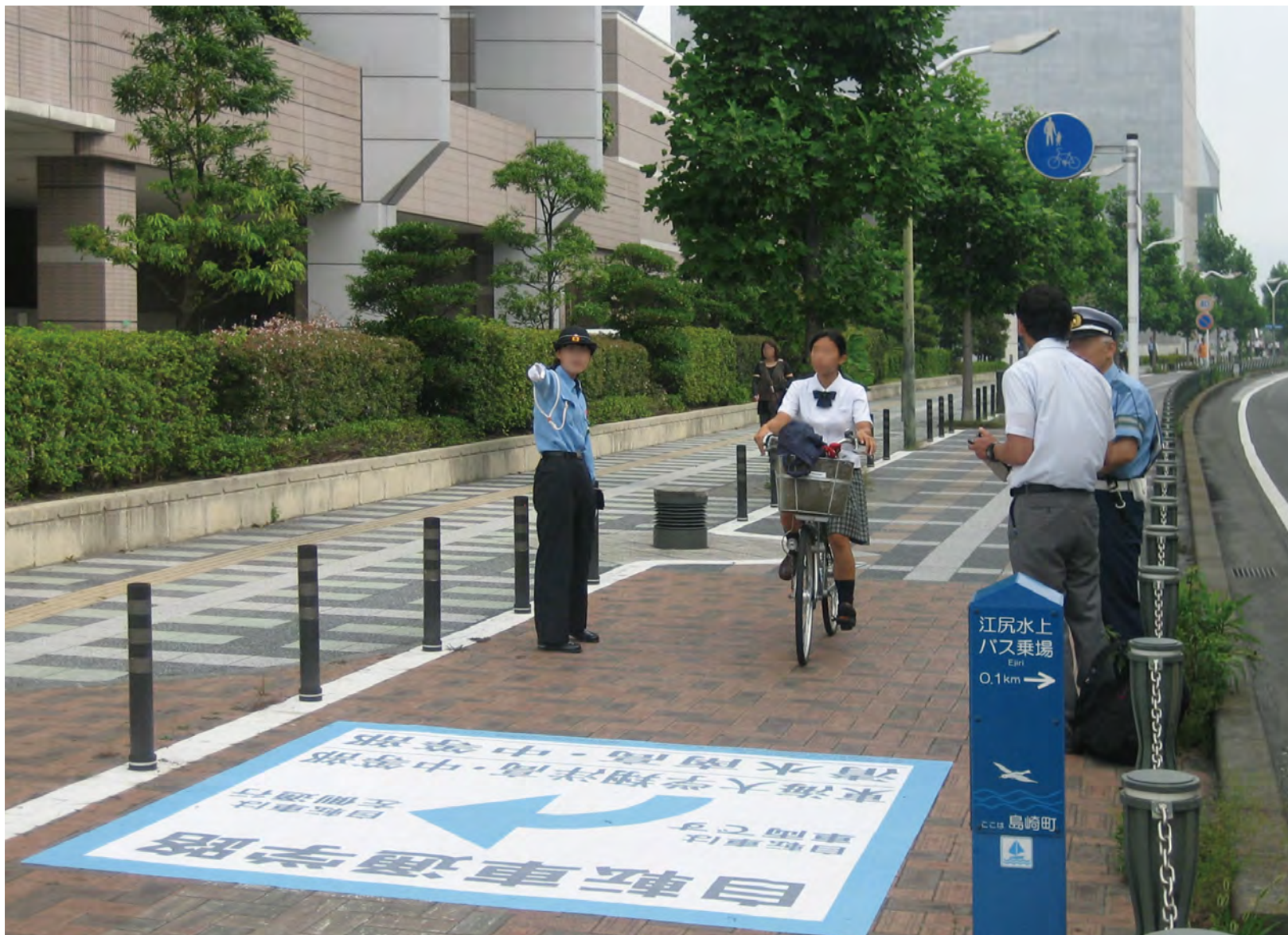
施工場所：静岡県 静岡市 サイズ：W2400×H2400mm
