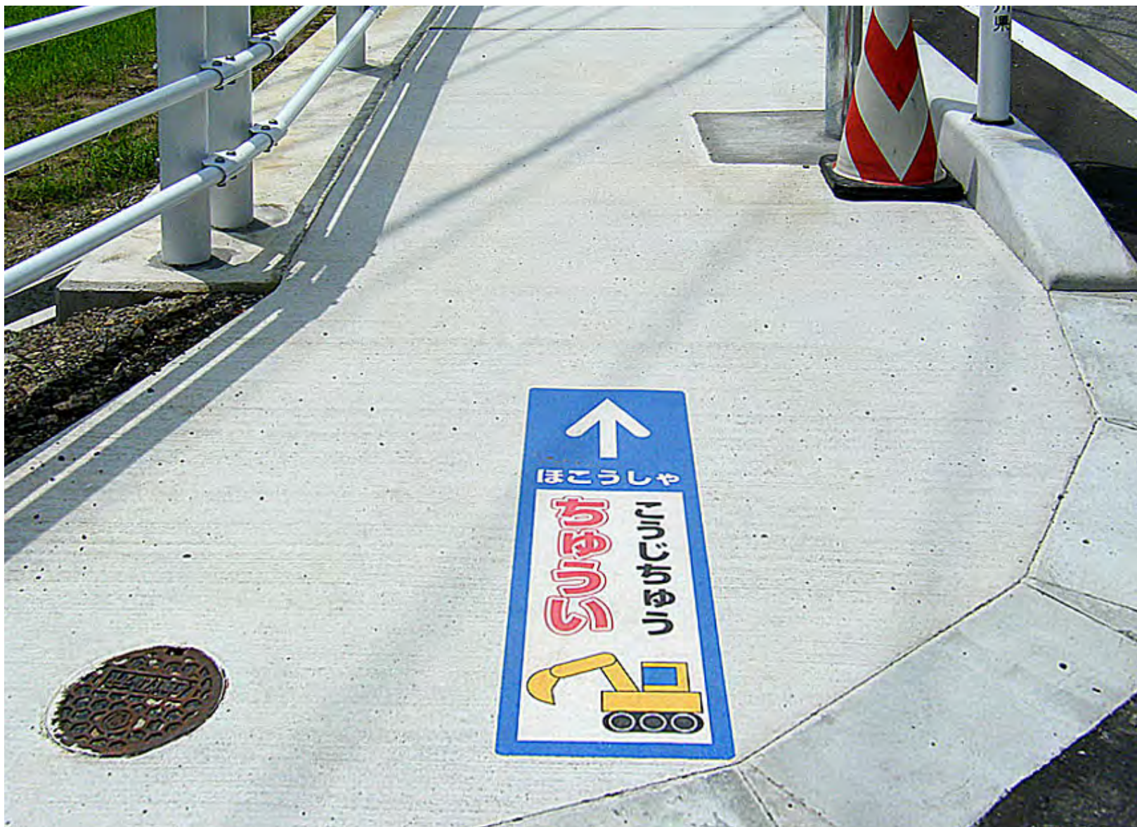
工事中 歩行者誘導
