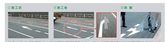
サポートライン黒を使えば、中央線・側線・矢印全部引き終わっても、矢印の先を隠すことが可能です。そのため供 用区間開通時に、矢印だけを引きにいく手間が省けます。また少ない人員で設置と撤去が可能なため、コスト面に もメリットがあります。
